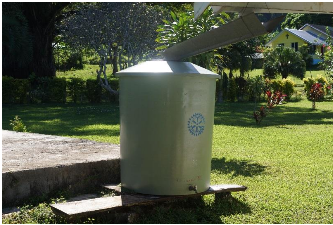
雨水を溜めるタンク
