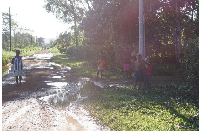
整備されていない道路は雨が降れば水溜り
